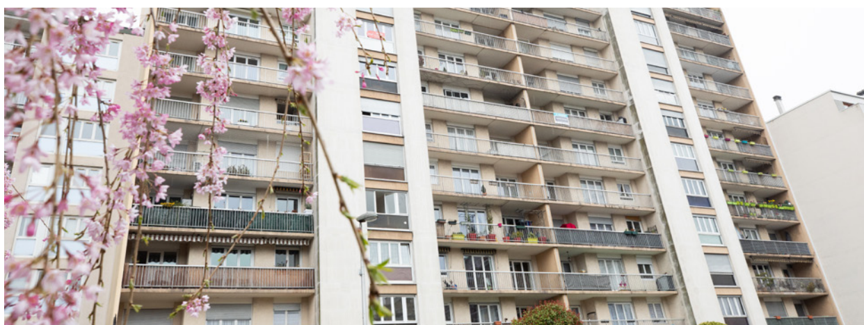
Une résidence de Rosny-sous-Bois (93) a fait réaliser des travaux de calorifugeage avec Hellio.
