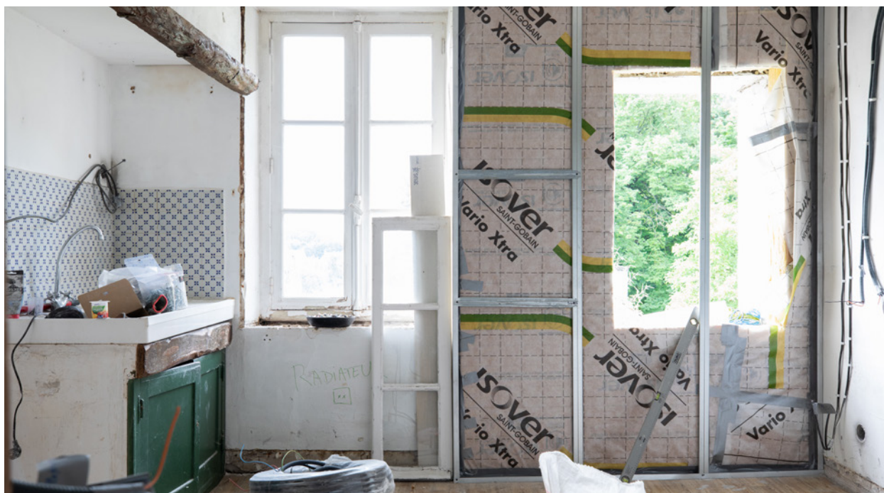
Rénovation globale réalisée par Hellio à Courteuil (60).
