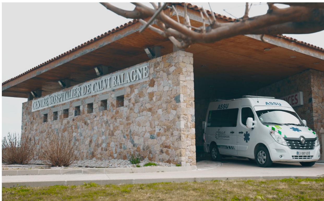
Le Centre Hospitalier Calvi Balagne a réalisé des travaux de calorifugeage et d'isolation des combles avec Hellio.
