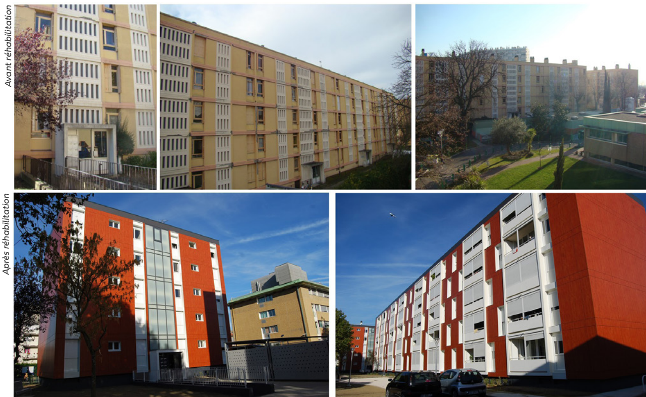
Exemple d'une réhabilitation de logements sur la résidence « Saint-Cyprien » à Toulouse menée par le Cabinet Rigual portant sur le ravalement des bâtiments avec une isolation thermique par l'extérieur (© Cabinet Rigual).
